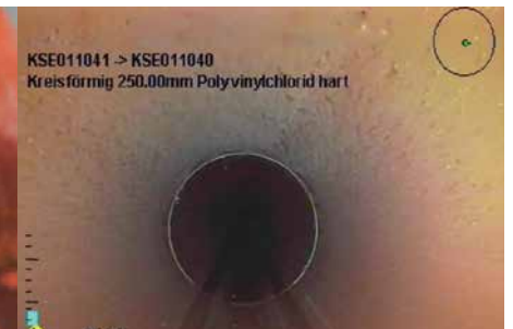
En bon état : inspection par caméra après 10 / 25 ans 0001.75 m
