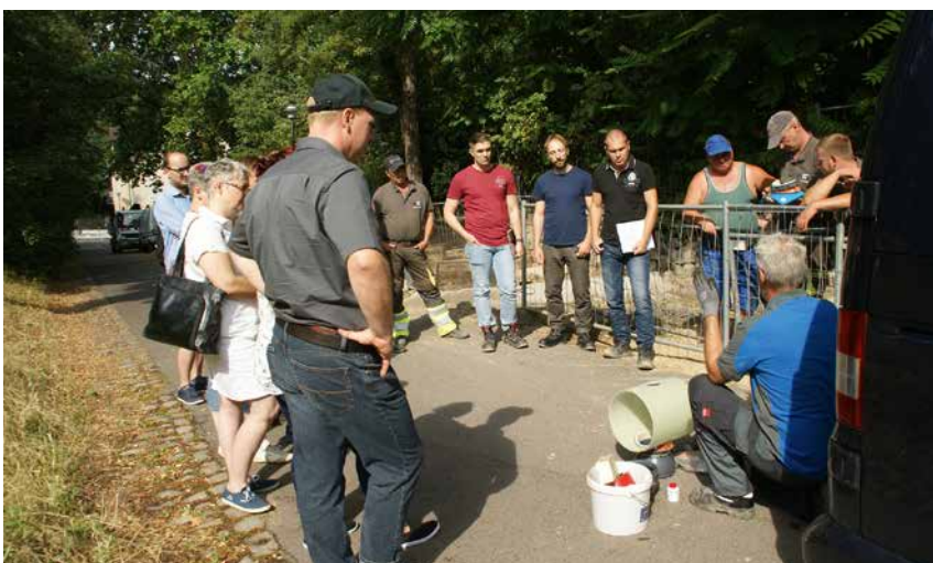
Im Sommer letzten Jahres erfolgte eine ausführliche Praxiseinweisung zum Liner-Anschluss System CONNEX durch die Funke Kunststoffe GmbH auf der Baustelle in Weißenfels.
