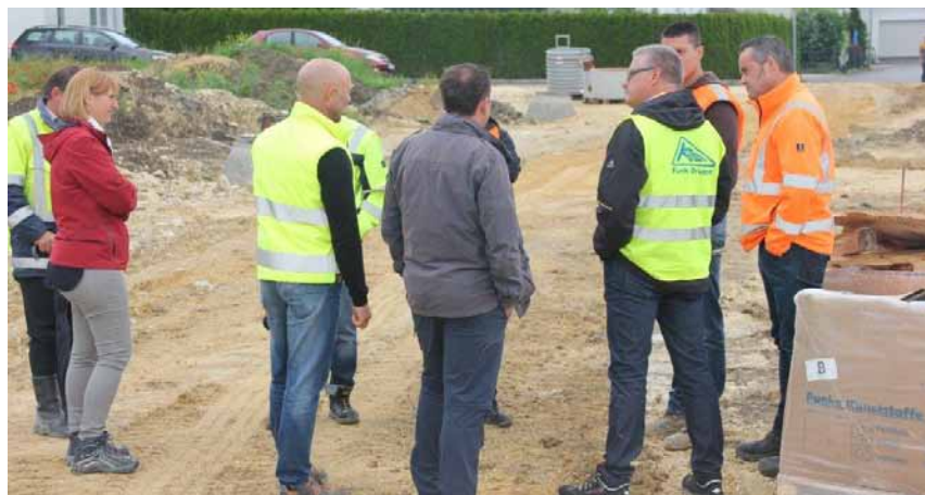
Bei einem Lokaltermin auf der Baustelle konnten sich Auftraggeber, Planer und Hersteller ebenso mit eigenen Augen von den Vorzügen und der Funktionsweise des Funke Schachtes überzeugen wie die Mitarbeiter verschiedener anderer Ingenieurbüros.
