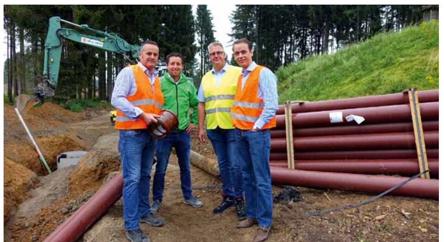
Für Robert Rühfel, Tiefbauamtsleiter in Leutkirch, Andreas Eugler, Bauleiter bei Max Wild, Gerald Barth, Fachberater von Funke Kunststoffe, und Dim Hemeltjen, Projektleiter für Center Parcs in Deutschland (v.l.), verläuft bei der Verlegung der HS®-Kanalrohre alles nach Plan.
