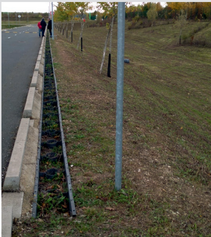
Caniveau épuratoire D-Rainclean® en version ouverte avec rejet dans une noue
