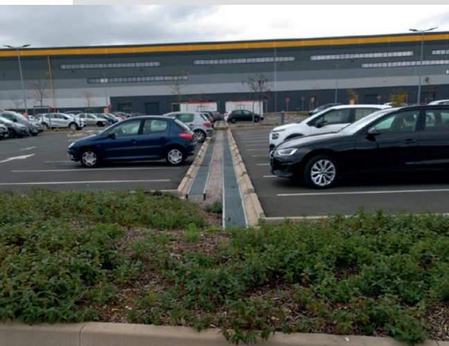
D-Rainclean® en version fermée sur le parking du personnel de l'entrepôt logistique Amazon
