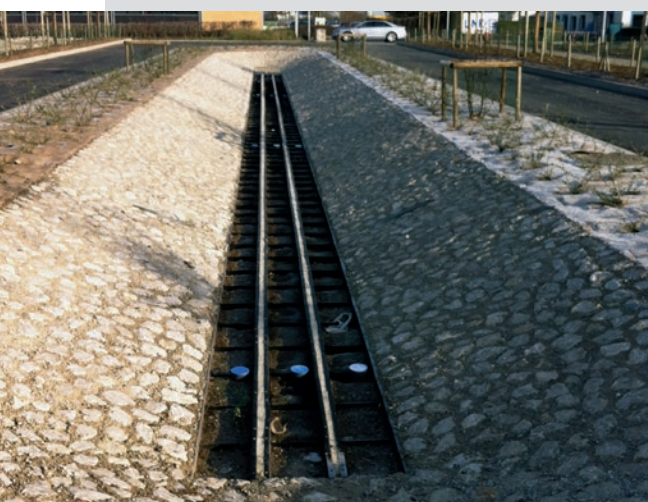
Pose du D-Rainclean(R) pour son intégration dans une noue végétalisée
